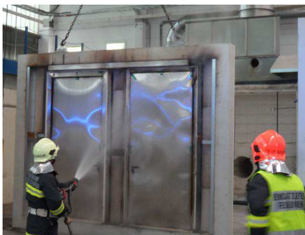
15.09.15: Brand einer Befeuungsanlage, Firma IVS, Obeltsham
